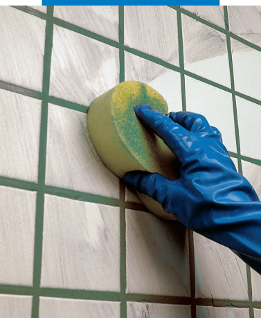
Čištění a konečná úprava obkladů houbou
