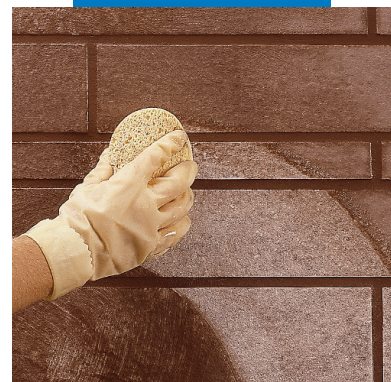
Čištění a konečná úprava spár houbou
