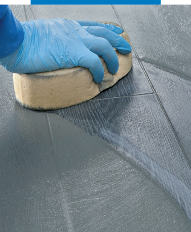
Čištění a konečná úprava spár v dlažbě typu gres tvrdou houbou z celulózy
