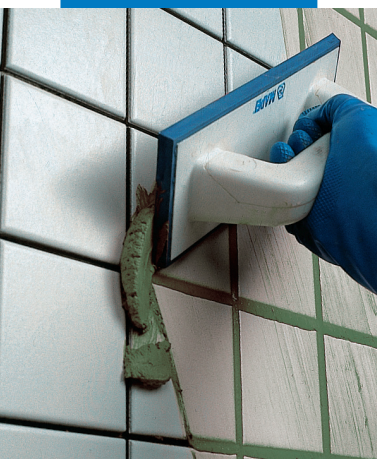
Nanášení Ultracoloru Plus gumovou stěrkou na obklad
