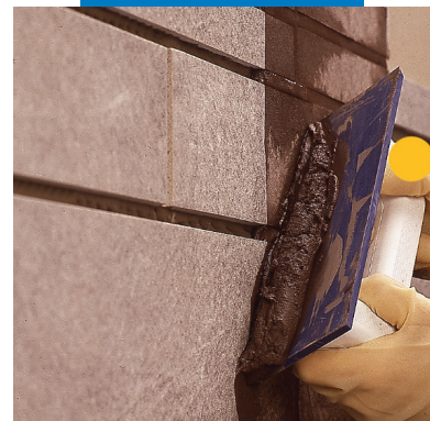
Nanášení Ultracoloru Plus gumovou stěrkou na stěnu
